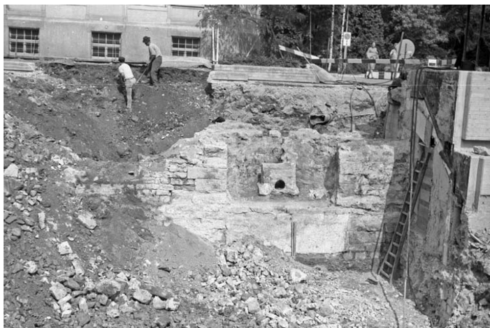
Freilegung der heute im Medizinischen Zentrum erhaltenen Apsis eines römischen Bades anlässlich der Bauarbeiten für den neuen Stadthof 1967-1969.
